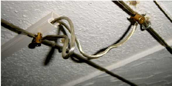
Laienhafter Anschluss einer 12 Volt Niedervolt - Beleuchtung
